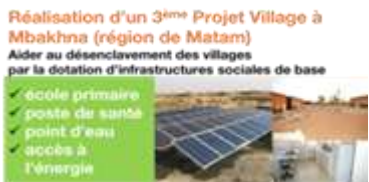
Réalisation d'un 3ième projet village avec Electrification en Energie Solaire
