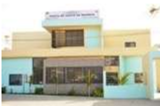
Construction et équipement du poste de santé de Mermoz
